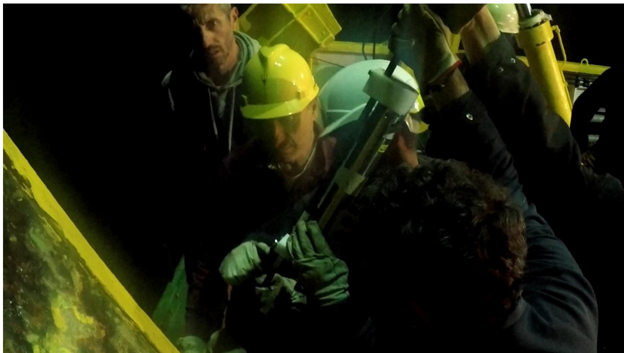
Εικόνα 41: Τοποθέτηση αισθητήρα τύπου SBE 37-IM MicroCAT στο επαγωγικό καλώδιο της σηματοδούρας της Πύλου.
