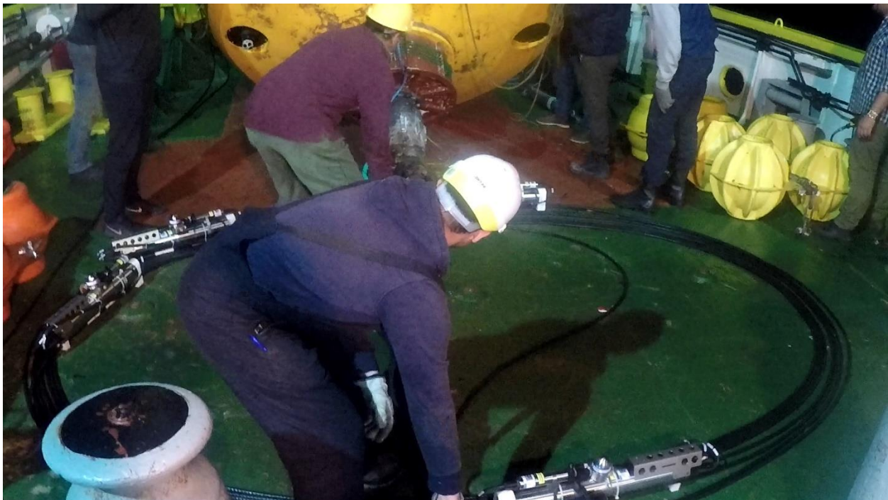
Εικόνα 40: Αισθητήρες τύπου SBE16 plus V2 τοποθετημένοι στο επαγωγικό καλώδιο της σηματοδούρας της Πύλου.
